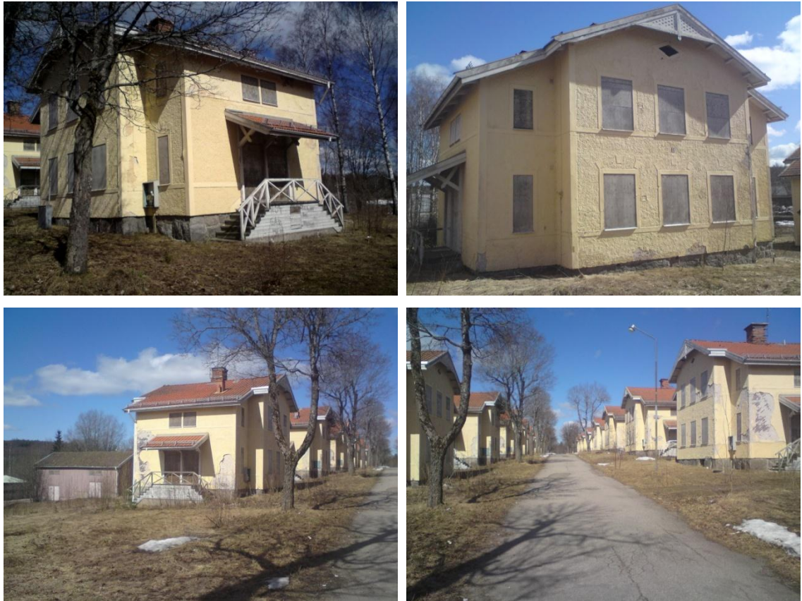
Bild 1-4. Områdets kvaliteter har upphört genom att fastigheten och byggnaderna sjangsarat. Husen har förändrats och av dess ursprungliga träbeklädnad syns inga spår, då husen försetts med puts.
