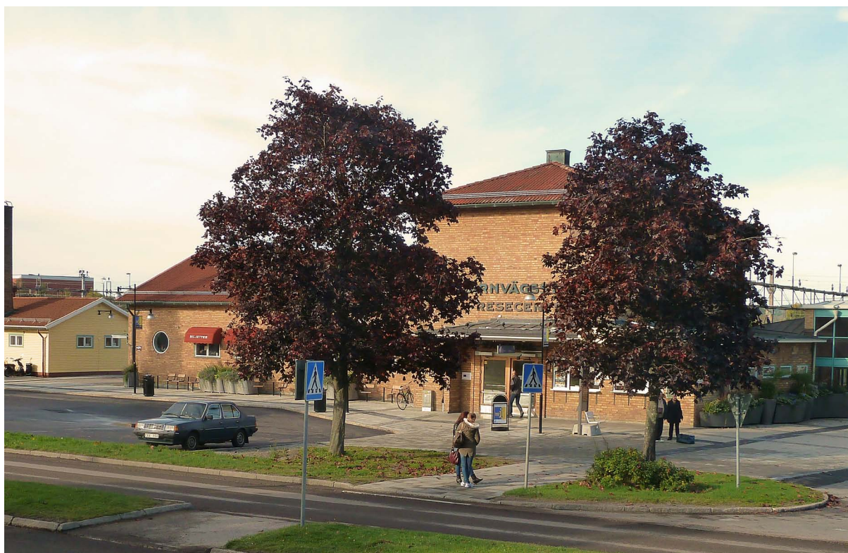
Passage över bergslagsgatan rv 50, vid resecentrum
