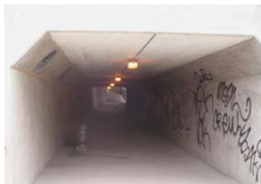
Tunnel under rv 50, förlängningen Carlavägen
