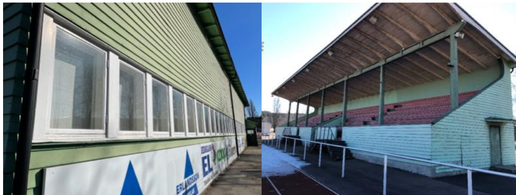
Läktarens södra fasad
