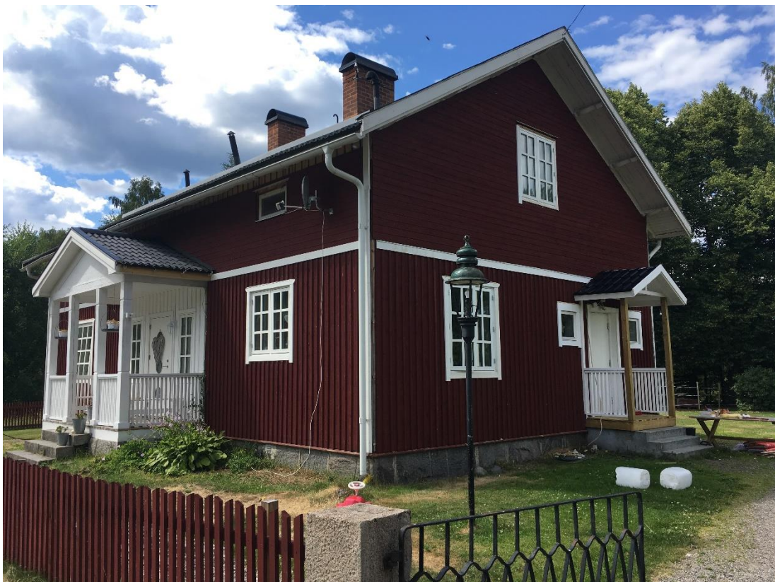
Ett karaktäristiskt hus för Klenshyttans by i Falu rödfärg och med både stående och liggande fasad där taklutningen är mellan 25-35 grader.
