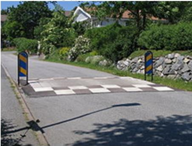
Figur 15. Exempel på cirkelgupp (även kallat Watts gupp). (Trafikverket, hämtat 2022-11-10)
